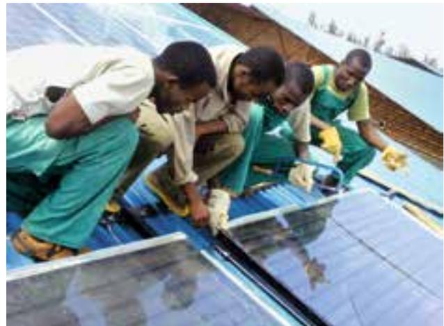
Installation de chauffe-eau solaires au Rwanda
